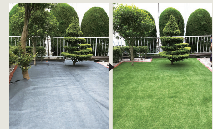
防草シート設置
