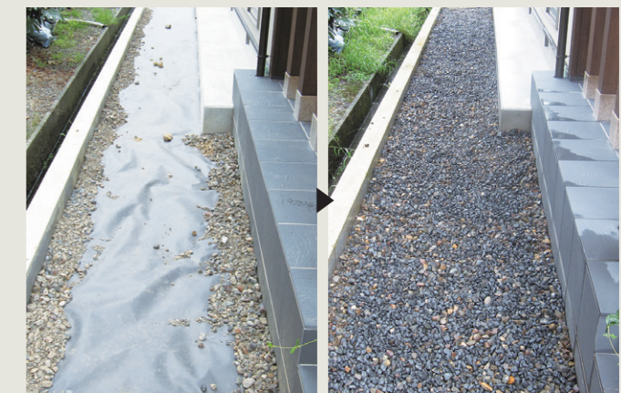
防草シート設置
