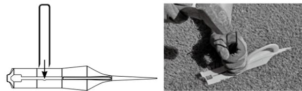
横長の穴に専用ピンを刺し、ハンマーでピンの頭が隠れるくらいまで打ち込みます。
