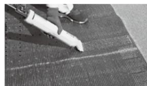
ボンドは裏面のステッチとクロスさせて塗布してください。
