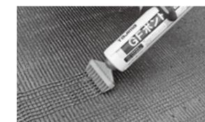
ボンドは裏面のステッチとクロスさせて塗布してください。
