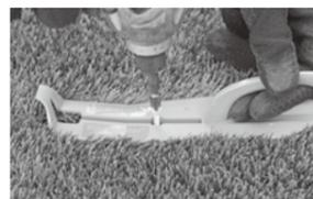
※パイルスプリッター<sup>®</sup>は全長30cmなので、次の打ち込み位置出しの目安とすると、よりスピーディーな施工になります。
