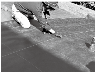
防草シートに穴あけ箇所のスミ付けを行います。
