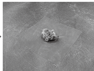
固定後、シート上より水やりを行い、施工完了となります。
