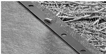
残りの穴をL型止めピンで固定し、施工完了となります。
