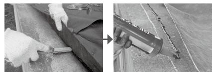
接着面(コンクリート表面)の汚れを金属ブラシで除去した後、口径約8mmにカットしたボンドの先端をシート下に差し込み、ボンドを注入します。
