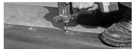
穴あけの際のコンクリートの粉を除去し、インパクトドライバーでワッシャーとともにビスをねじ込み、施工完了となります。
