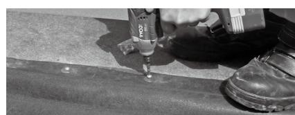
穴あけの際のコンクリートの粉を除去し、インパクトドライバーでワッシャーとともにビスをねじ込み、施工完了となります。
