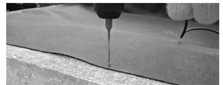
ビスの間隔は20～50cmで、シートの上からハンマードリルで下穴をあけます。直径は3.4～3.5mm、下穴の深さはねじ首下長さの+10mm程度が目安です。
