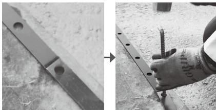
フラットバーのジョイント部同士を合わせ、ジョイント部にL型止めピンで接続します。
