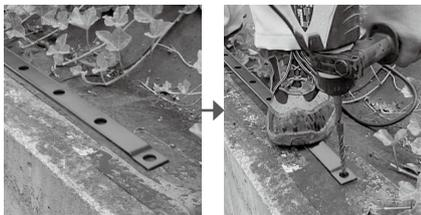
フラットバーを敷き並べたら、足で固定し、ハンマードリルで下穴をあけます。直径は8.5mm、下穴の深さはねじ首下長さの+10mm程度が目安です。
