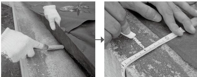
接着面(コンクリート表面)の汚れを金ブラシで除去した後、シート端部から50mm程度外側にスミ付けを行います。
