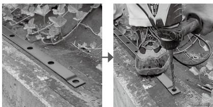
フラットバーを敷き並べたら、足で固定し、ハンマードリルで下穴をあけます。直径は8.5mm、下穴の深さはねじ首下長さの+10mm程度が目安です。
