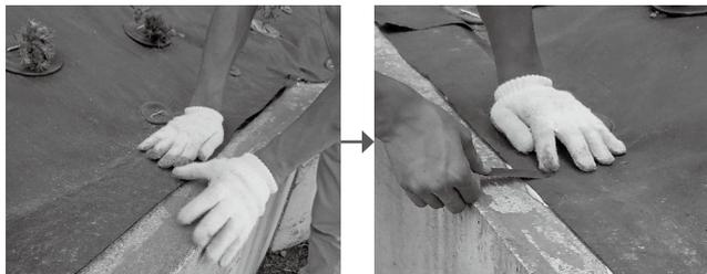
ボンド塗布後、シートの上から軽く押し、シートとコンクリートにボンドを馴染ませます。ボンドの養生時間があるため、接続テープを数か所貼り、施工完了となります。
