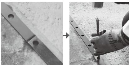
フラットバーのジョイント部同士を合わせ、ジョイント部にL型止めピンで接続します。
