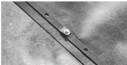
穴あけの際のコンクリートの粉を除去します。アンカーボルトとフラットバーの間にワッシャーを挟み込み、インパクトドライバーでねじ込みます。2本目のフラットバーを連結して固定し、最後に中間部を固定し、全て固定したら施工完了となります。
