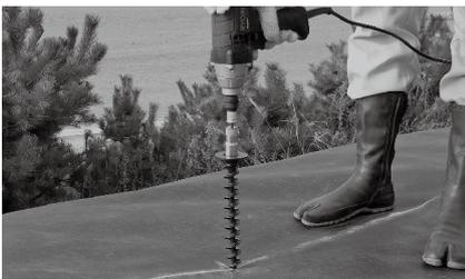
ピンを打つ位置をスミ付けした後、インパクトレンチでピンをシートに直接ねじ込みます。仕上げにピンの上から防草パッチ®を貼ってください。ガンコピン®はリサイクルポリプロピレン製なので錆びることがなく、耐久性に優れています。
