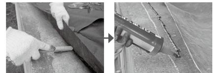
接着面（コンクリート表面）の汚れを金ブラシで除去した後、口径約8mmにカットしたボンドの先端をシート下に差し込み、ボンドを注入します。
