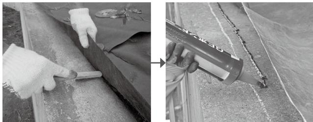
接着面(コンクリート表面)の汚れを金ブラシで除去した後、口径約8mmにカットしたボンドの先端をシート下に差し込み、ボンドを注入します。
