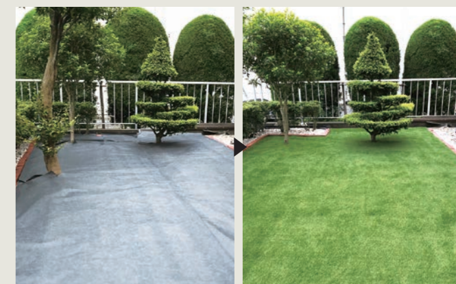
防草シート設置
