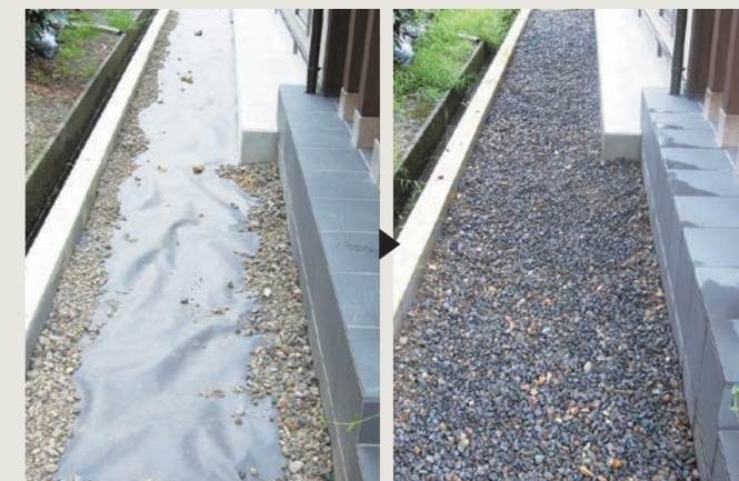
防草シート設置
