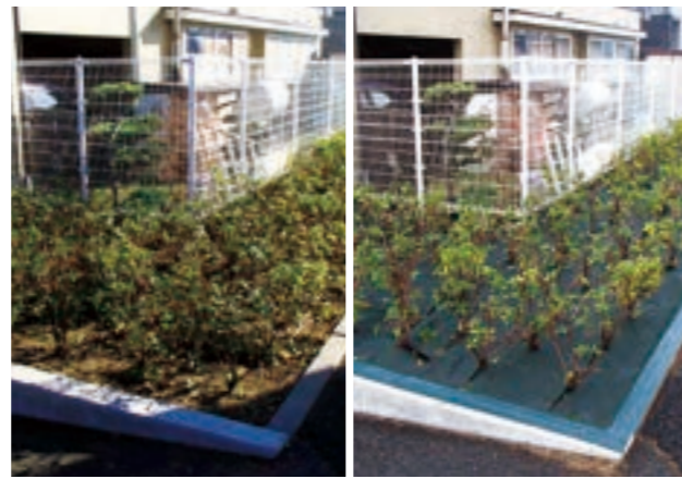
施工前 → 施工後
