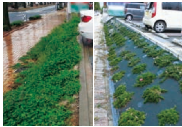
施工前 → 施工後
