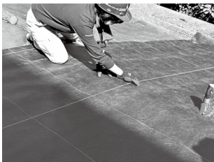
防草シートに穴あけ箇所のスミ付けを行います。
