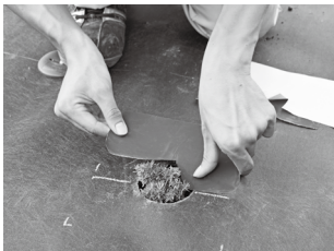
切れ目のある方を穴の中心線から10mm越えた位置に合わせて貼ります。
