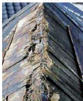
腐朽菌により老朽化した屋根
