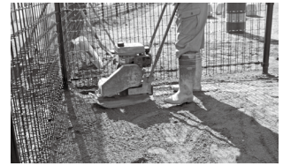
不陸が出てしまった例 しっかり整地ができていないと 地面の不陸が出てしまい、仕上 りが悪くなってしまいます
